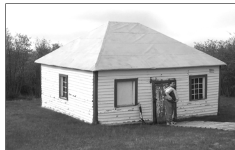
La bibliothèque, détachée de ses fondations. (K. Skaftfeld)
