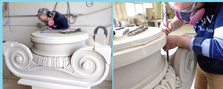
Un ouvrier qualifié apporte les décorations finales au chapiteau ionique qui sera installé sur la colonne sud-ouest du portique sud. Soumis par Trevor Gillingwater, expert-conseil en restauration de pierre pour le projet de restauration du lieu historique national Province House.
