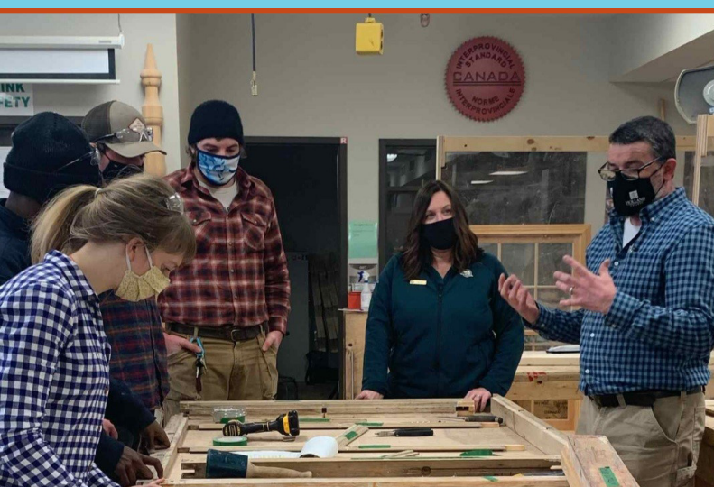
Des étudiants du programme de menuiserie patrimoniale du Collège Holland examinent l'état des cadres de bois dénudés. Les travaux de conservation des fenêtres ont commencé en 2019, sous la direction de Josh Silver, responsable de l'apprentissage pour le programme de menuiserie patrimoniale. Au printemps, des étudiants ont réinstallé les fenêtres au lieu historique national Province House.
