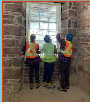
Des étudiants réalisent le processus complexe de réinstallation de ces fenêtres centenaires au lieu historique national Province House.
