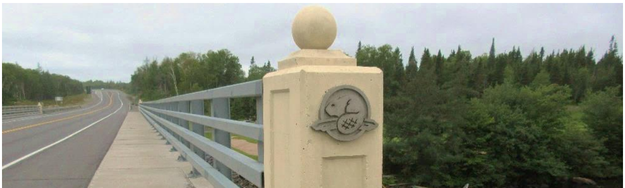
Pont sur la Transcanadienne dans le parc national Terra-Nova, 2019.
