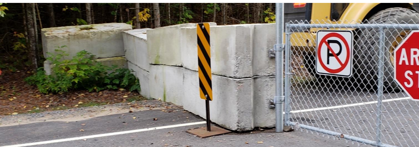
Route fermée en raison de travaux routiers dans le parc national de la Mauricie, 2019.
