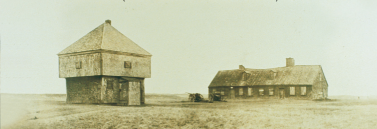
Quartiers des officiers (détruits lors d'un incendie en 1922) avec le blockhaus.
