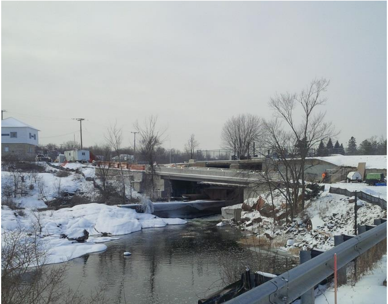
Remplacement du pont fixe de Kingston Mills
