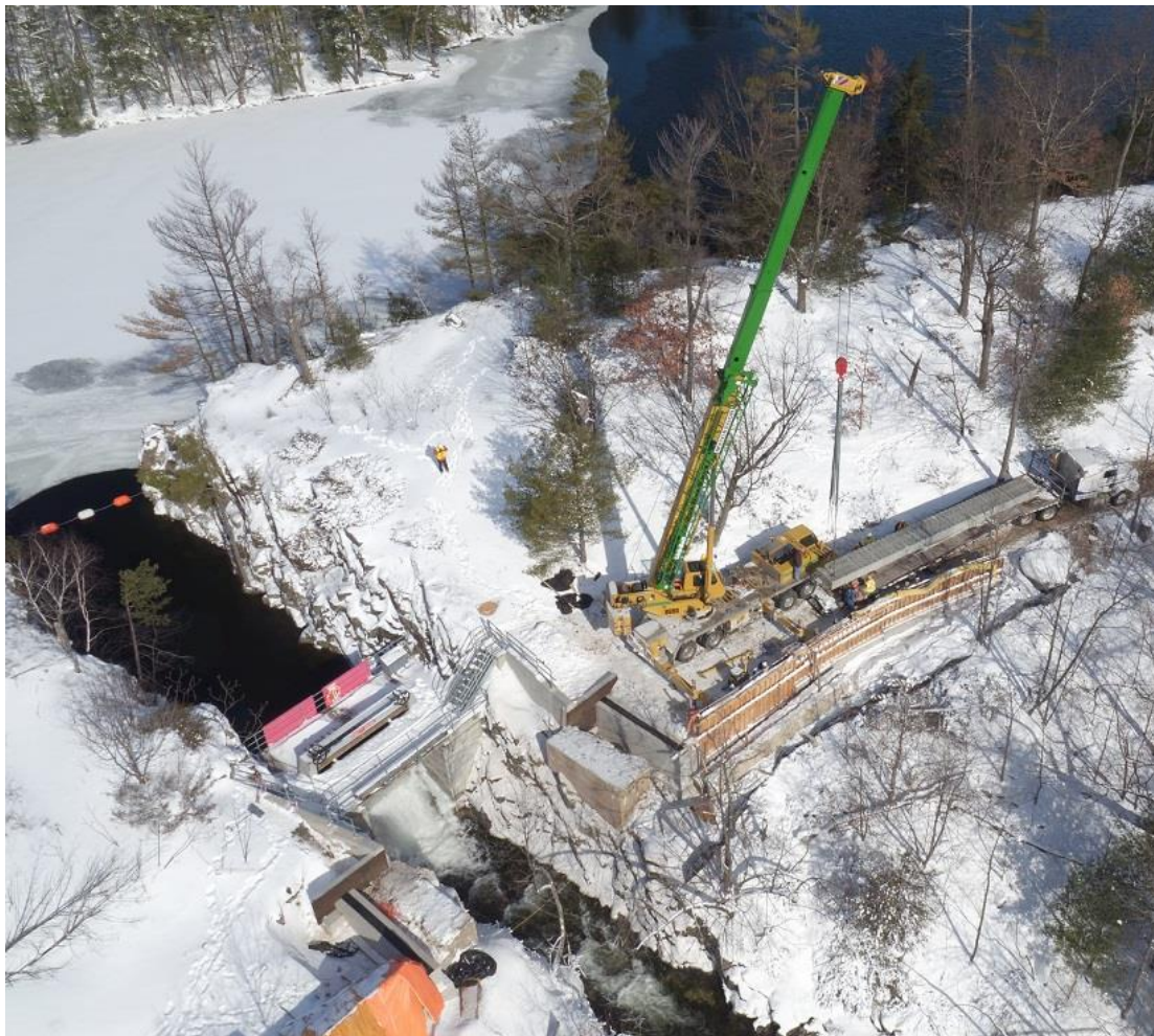
Installation de poutres au pont de béton de Jones Falls
