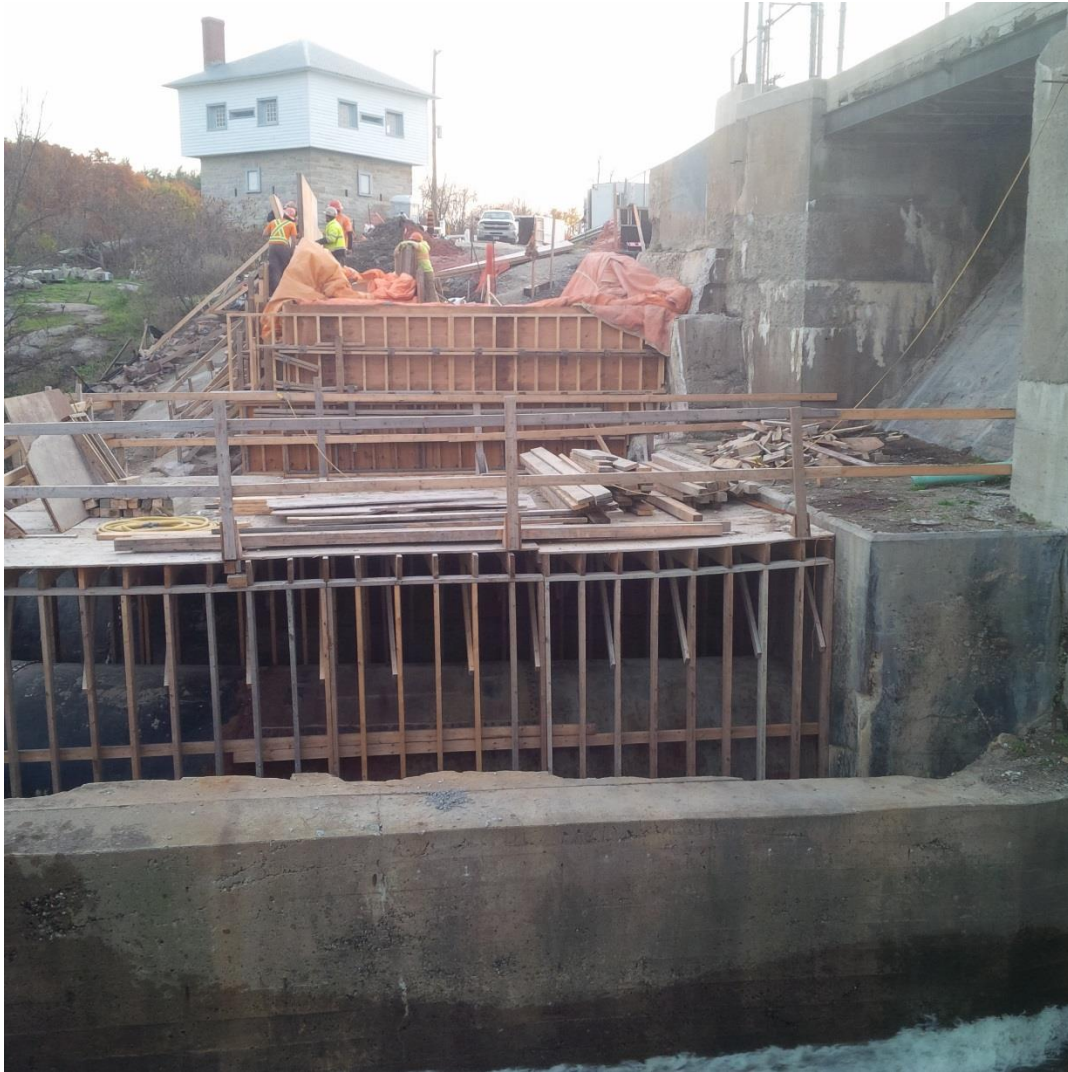
Réfection du pont fixe de Kingston Mills
