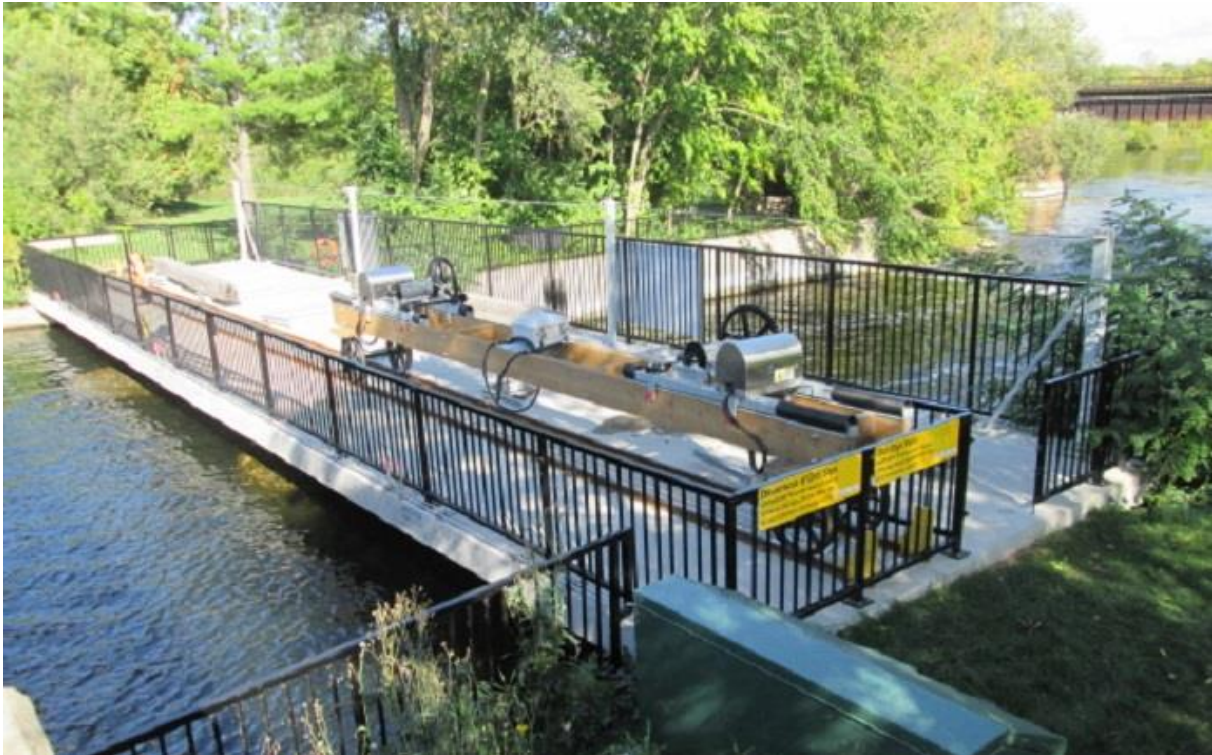
Déversoir d'Old Slys
