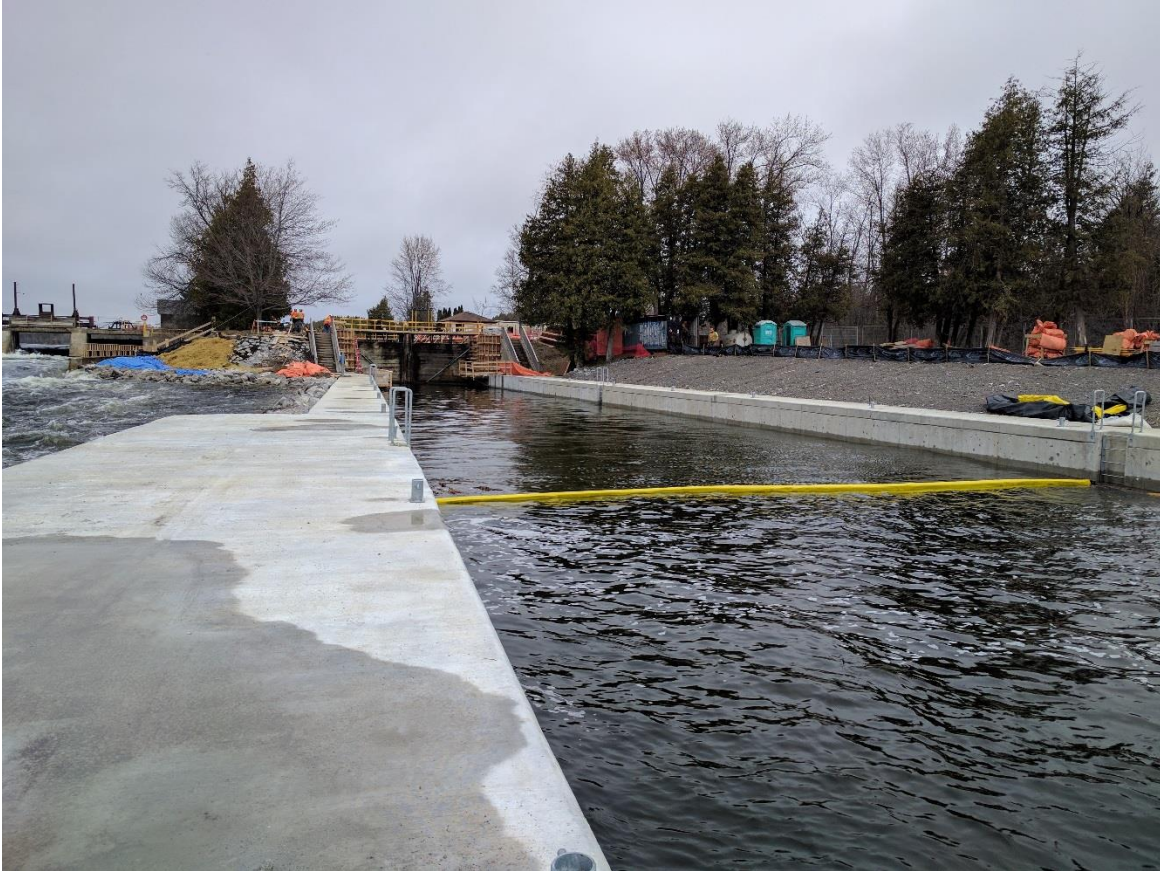
Travaux de réparation de l'écluse 25 au ruisseau Sawyer
