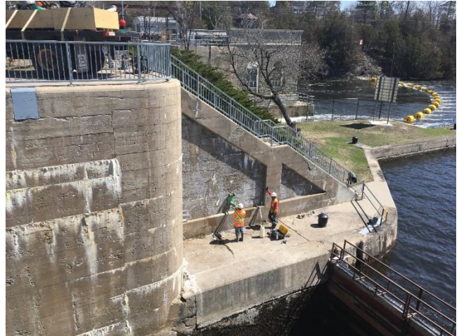
Travaux de carottage sur la structure de l'écluse 14 à la baie Crowe, en avril 2017
