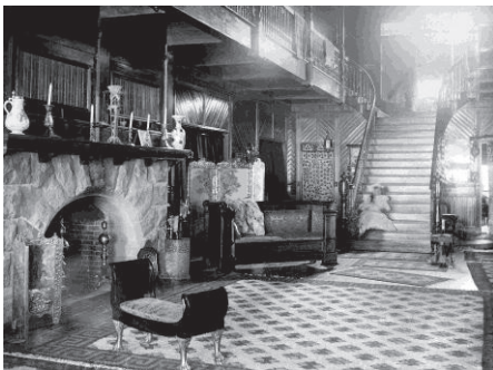
Le foyer impressionnant au rez-de-chaussée – Parcs Canada
