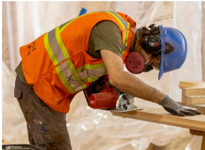
L'équipe de menuiserie utilise du pin blanc, le matériau d'origine, pour remplacer les segments de plancher usés ou pourris
