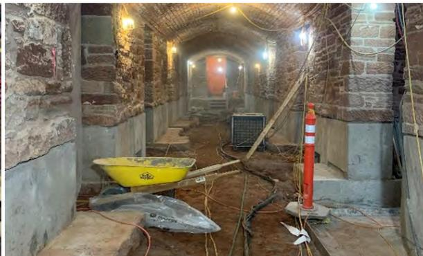
Après les travaux de consolidation du sous-sol. Le sol du sous-sol a été abaissé d'un mètre afin que cette partie du bâtiment devienne un espace utilisable et accessible.
