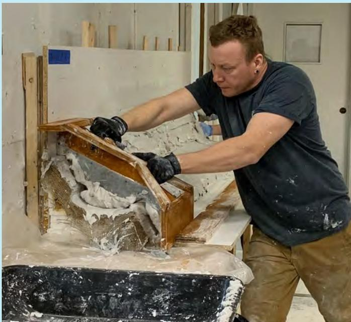
Un plâtrier qui traîne le gabarit sur le banc. Cette opération est effectuée environ 40 à 50 fois dans un laps de temps de 20 à 25 minutes.
