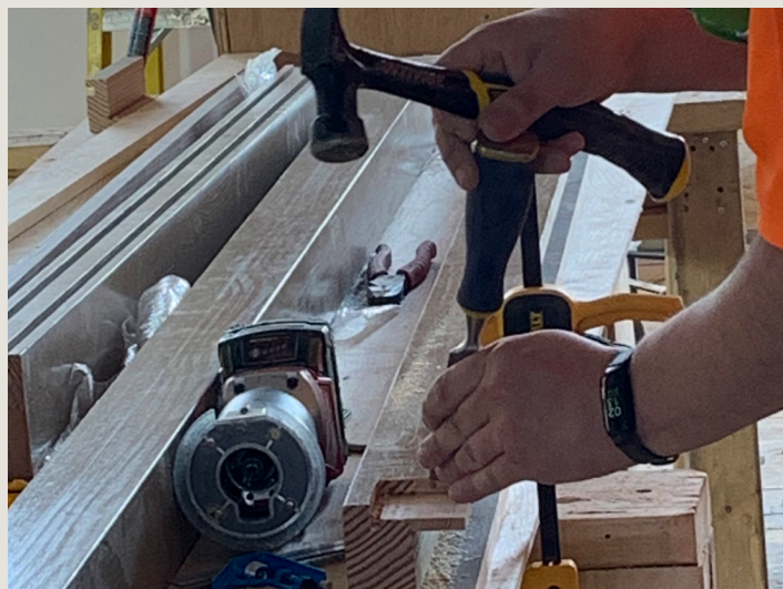
Un ouvrier cisèle à la main un morceau de garniture pour assurer une installation précise
