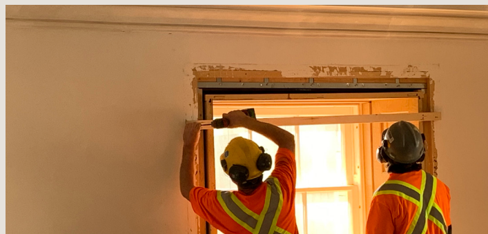
Renforcement temporaire du cadre de la fenêtre restaurée avant son installation définitive
