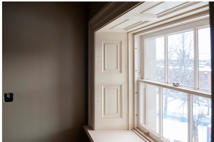
Progression des travaux liés au plâtrage, à la peinture et aux moulures, pièce par pièce
