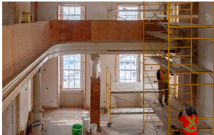
Le plâtrage de certains murs plus hauts a nécessité la mise en place d'un échafaudage
