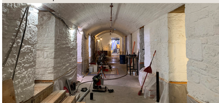
Le badigeonnage à la chaux du sous-sol protège la maçonnerie et illumine l'espace
