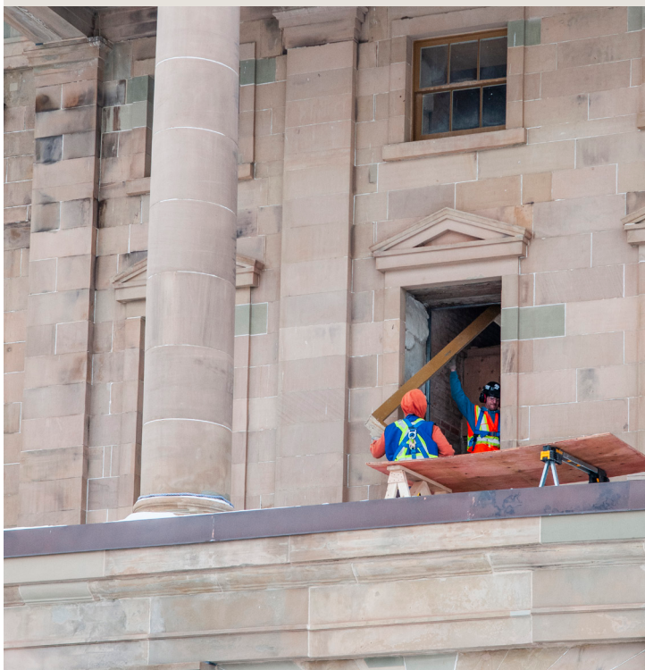
Chargement de matériaux de construction par la fenêtre du portique
