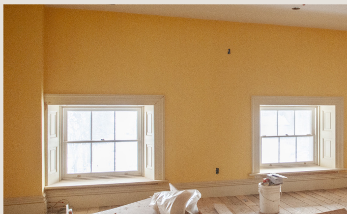
Restauration et réinstallation des cadres de fenêtres dans une pièce plâtrée et peinte au troisième étage
