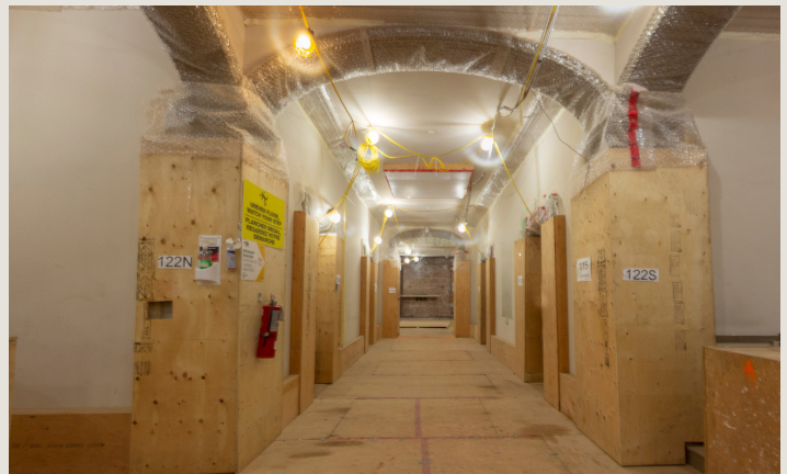
Le contreplaqué et le film à bulles protègent les garnitures et les planchers pendant le projet
