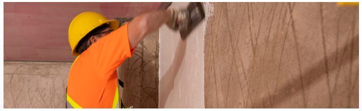
Pose de la troisième couche de plâtre
