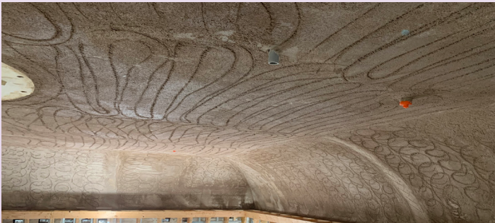
Plafond incurvé montrant la deuxième couche avec des tourbillons qui facilitent l'adhérence de la troisième couche
