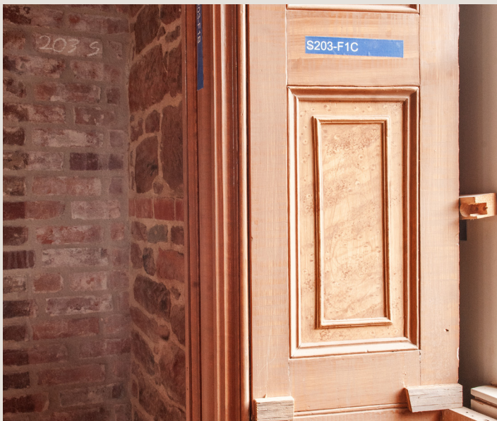
Cadres des fenêtres, montrant l'épaisseur des murs extérieurs
