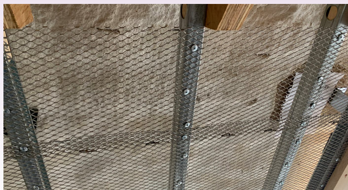
Le lattis métallique accroît la solidité et la longévité de l'ouvrage.
