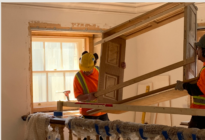
Gary Loo et un collègue déplacent avec précaution les garnitures d'une fenêtre
