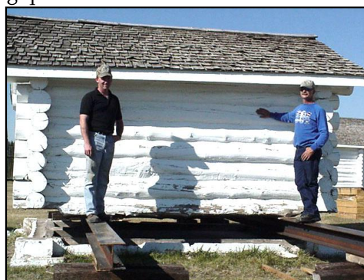
Réparation des bâtiments du poste de remonte au LHNC du Fort-Walsh. (Parcs Canada)
