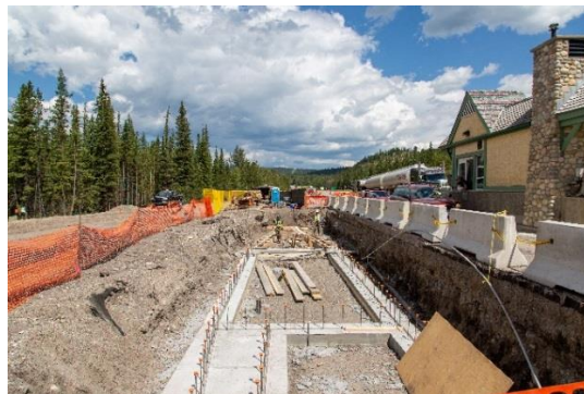
Travaux en cours au poste d'entrée Est. © Parcs Canada / S. Potter
