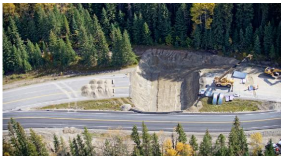
Construction de l'un des six nouveaux passages inférieurs à l'automne 2015
