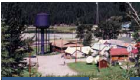
Les commerces devraient être regroupés autour du château d'eau.
