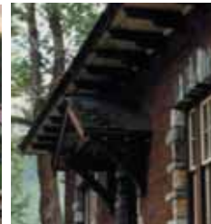
Le Telegraph Building se détériore.
