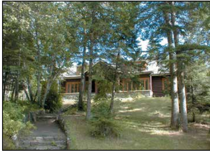
Illustration 2-17 Maison quadrifamiliale (logement du parc)
