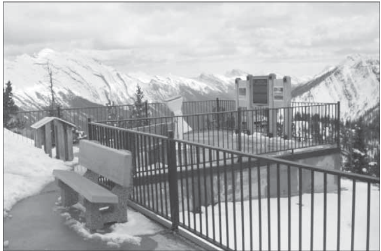
Vestiges des fondations en béton de la station d'étude des rayons cosmiques du Mont-Sulphur. Agence Parcs Canada.
